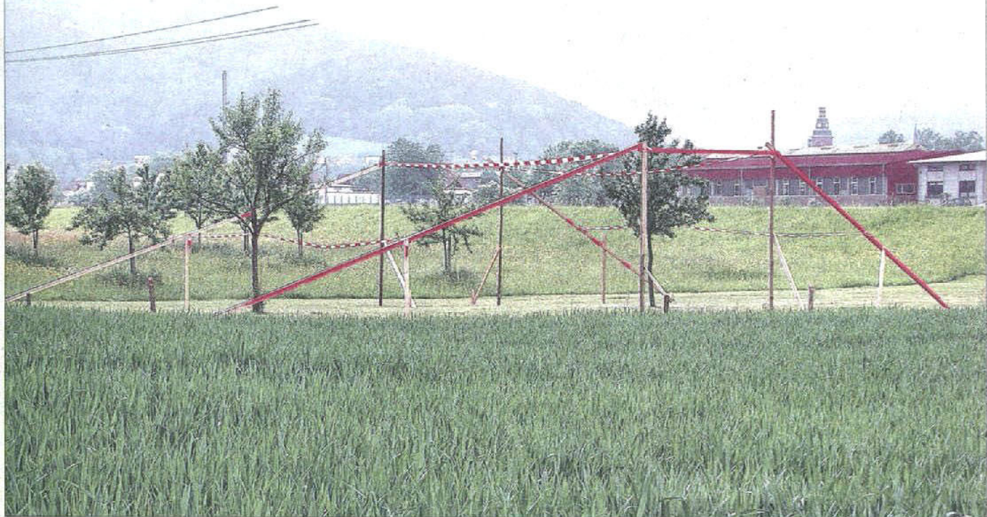
Breitere Dammsohle und höhere Krone: Anhand eines Lattengerüsts ist aktuell im Kinzigvorland bei Schnelllingen zu sehen, wie sich eine B-33-Umfahrung auswirken würde.
